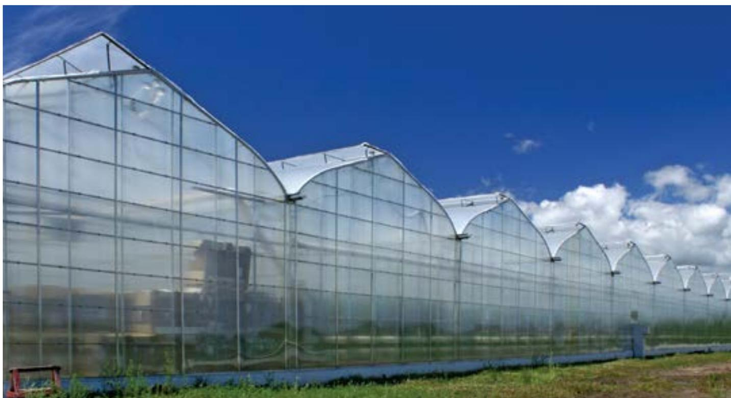
Polycarbonate 8 mm: il s'agit d'un revêtement rigide à double paroi qui offre une excellente durabilité et une bonne isolation.
