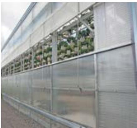
Ventilation enroulable sur mur rigide
