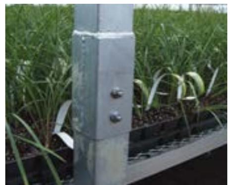
**Les gouttières de la Luminosa** reposent sur des supports monopieces modernes, qui minimisent le nombre de pièces requises à l'installation, tout en conférant une résistance accrue.
